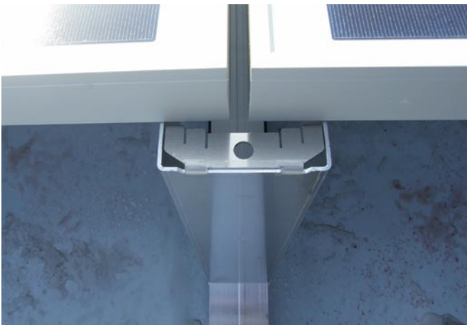
Fugenbild überprüfen und richten.
