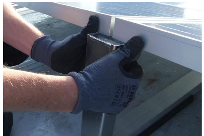
Nächsten Heckträger hochklappen.
