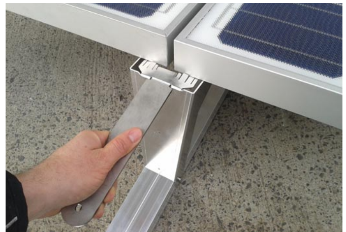
Sicherungen etwas hochbiegen.
