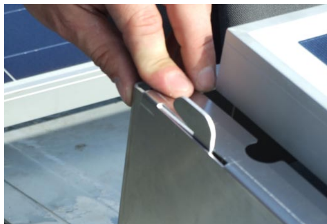
Nut auf Heckträger einfädeln und
