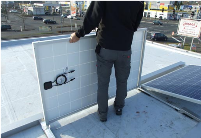
Modul senkrecht auf die Schienen
