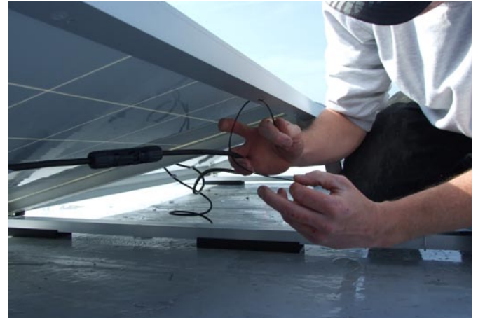
Kabelbinder in Rahmenbohrung
