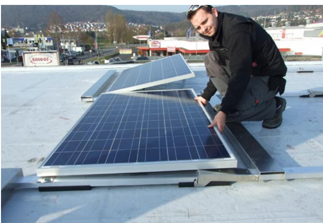
Modul flach nach hinten ablegen
