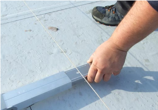
Verbinder einschieben und weitere
