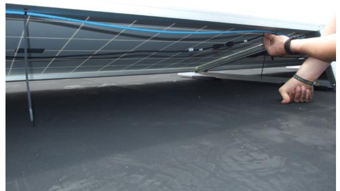
Möglichst mit Stringrückführung.
