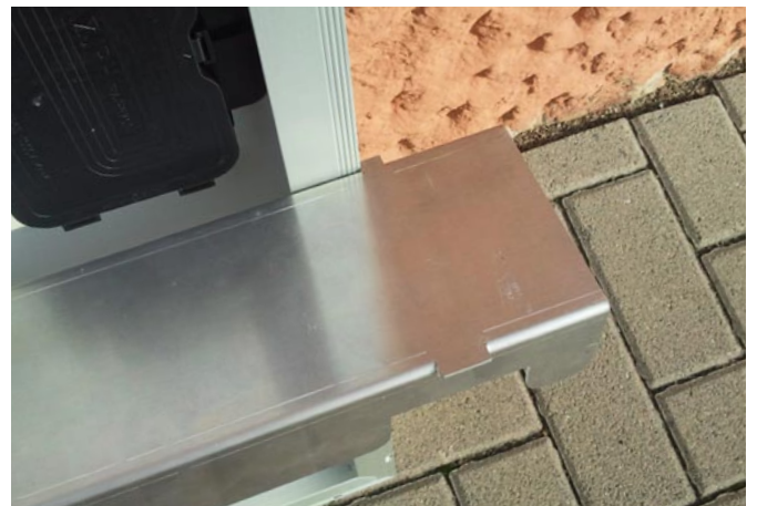
Zur Längeneinstellung schmale Nasen am Modulrahmen andrücken.
