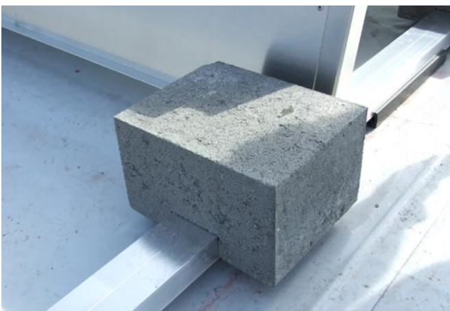
Ballaststeine nach Plan auflegen
