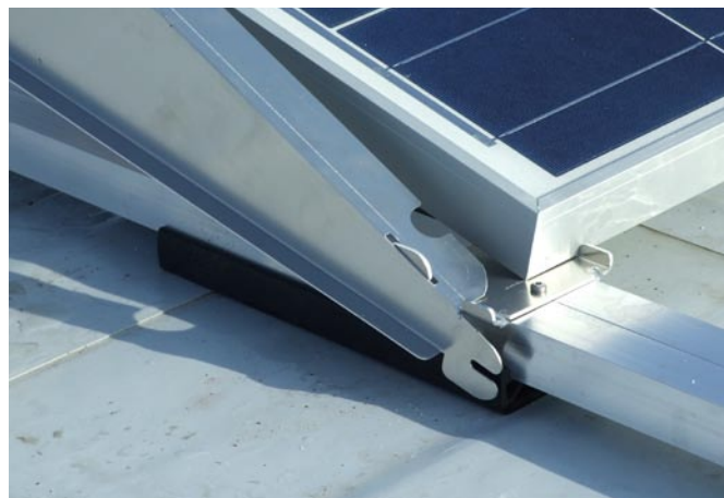
Seitenblech vorne mit Nut auf
