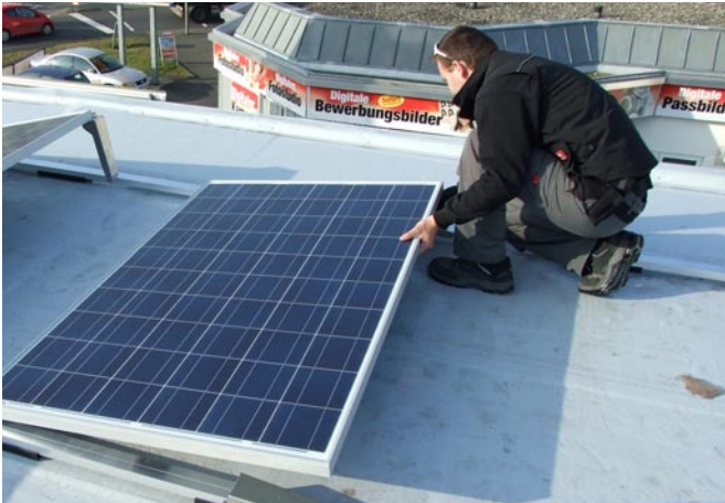
Modul bis Sollneigung aufrichten.
