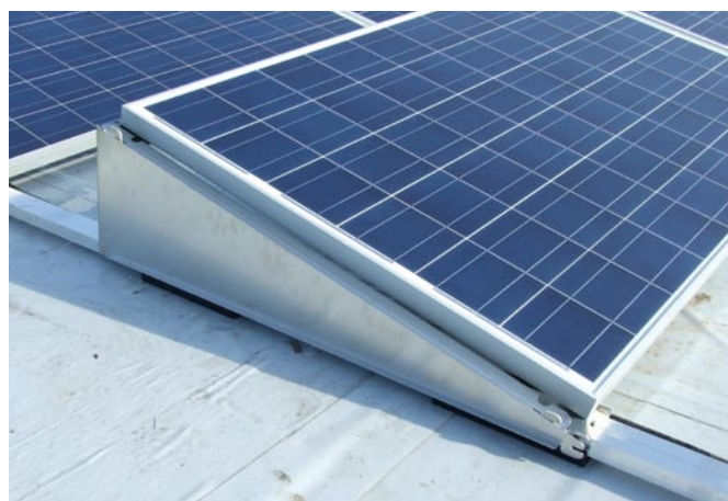
Seitenblech fertig montiert.
