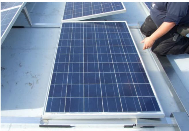
Nächstes Modul ebenso einbauen.
