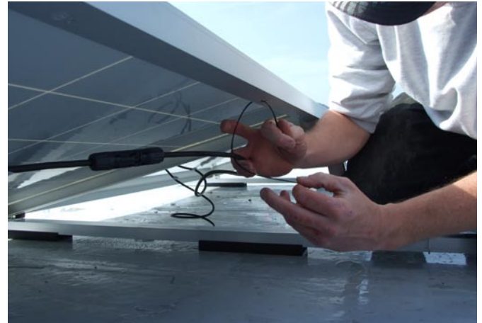
Kabelbinder in Rahmenbohrung
