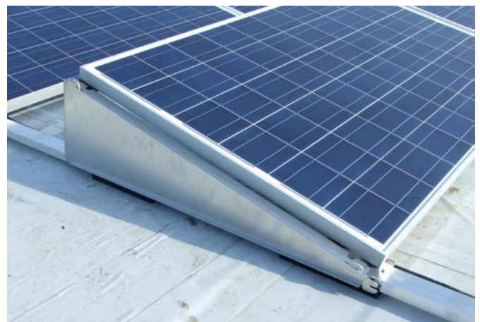
Seitenblech fertig montiert.
