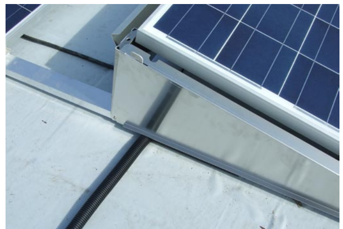
Kabelbrücken.
