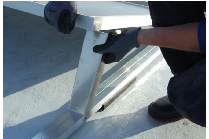
Äußeren Heckträger hochklappen.
