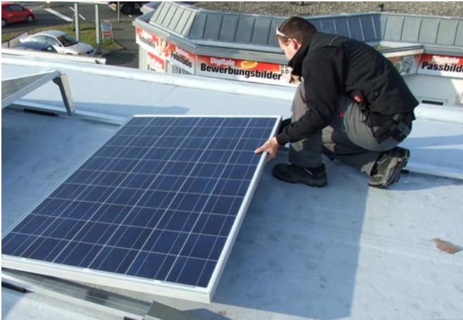
Modul bis Sollneigung aufrichten.
