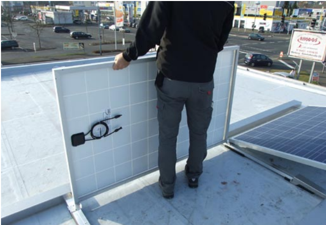
Modul senkrecht auf die Schienen
