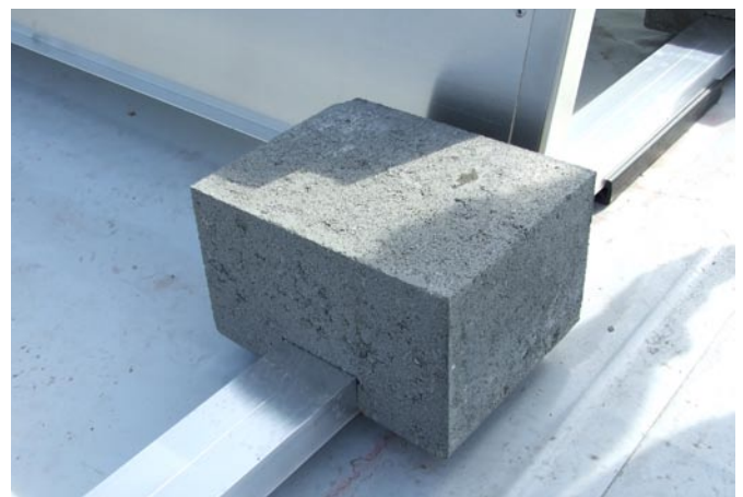
Ballaststeine nach Plan auflegen
