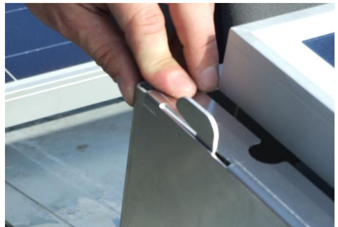
Nut auf Heckträger einfädeln und
