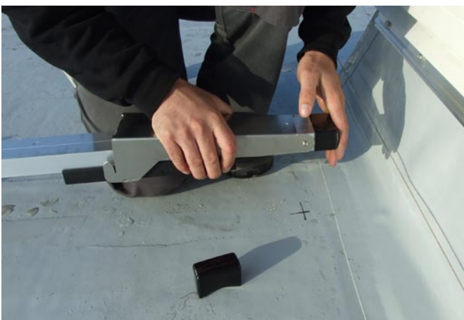
Kappen an Rohrenden anbringen.
