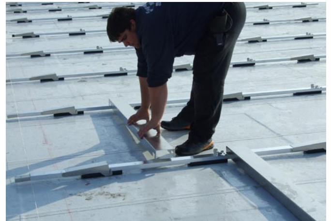
Schienen an Schnur platzieren.
