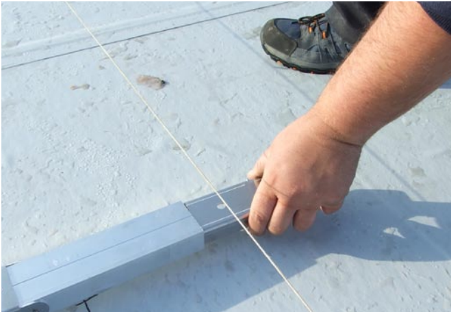
Verbinder einschieben und weitere
