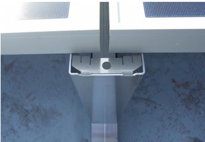
Fugenbild überprüfen und richten.
