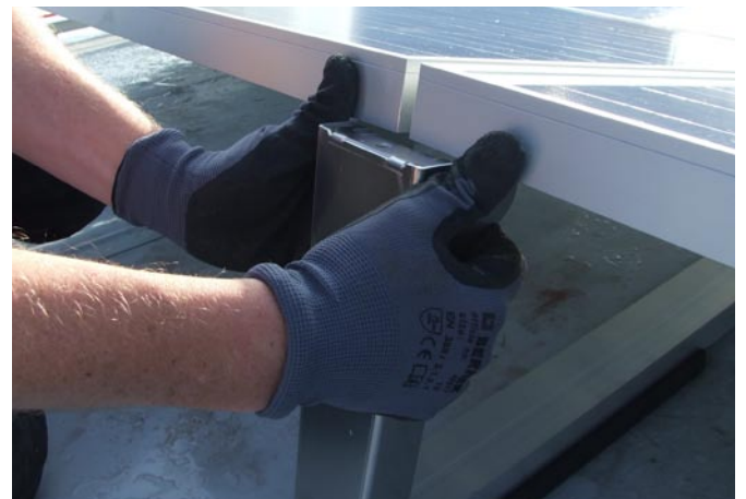
Nächsten Heckträger hochklappen.
