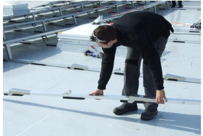
Schienen im Norden ansetzen.
