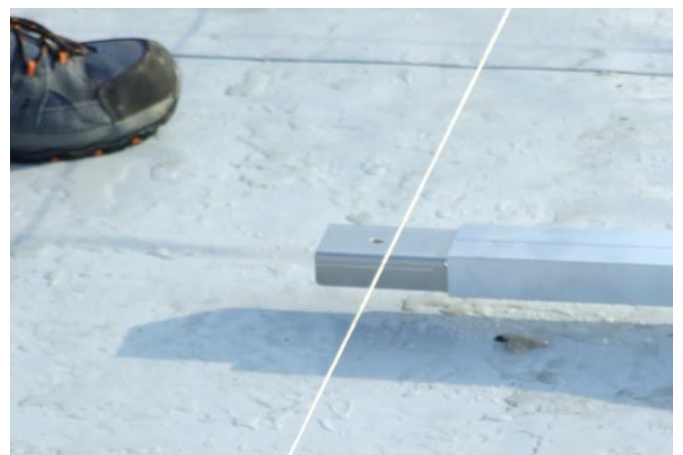
Schnur, Schlagschnur oder Laser
