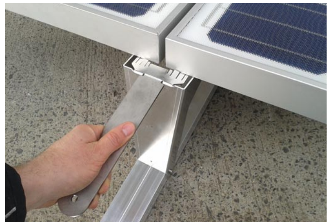
Sicherungen etwas hoch biegen.
