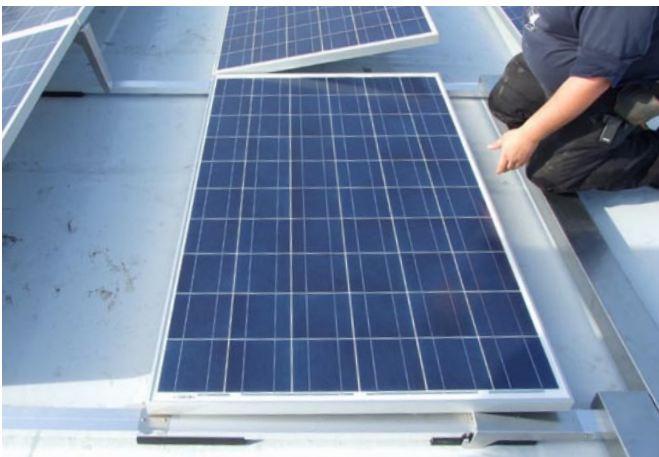
Nächstes Modul ebenso einbauen.
