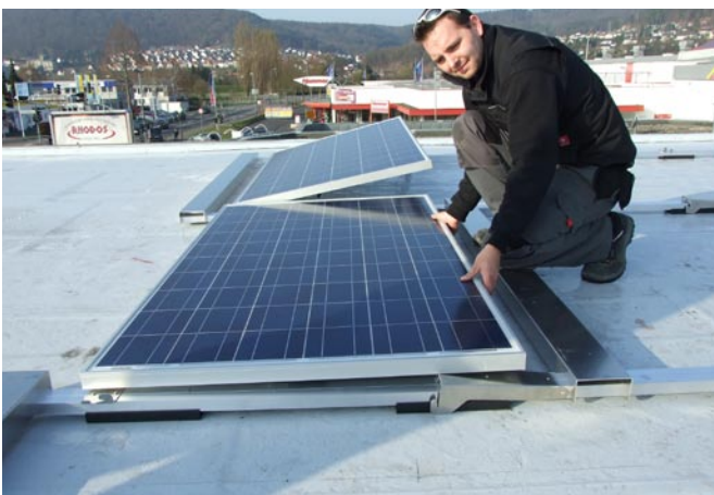
Modul flach nach hinten ablegen
