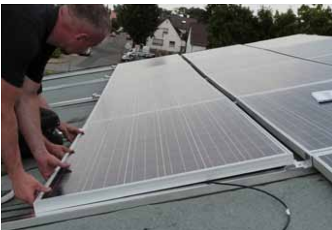
Modul in den ilzoclip ziehen.
