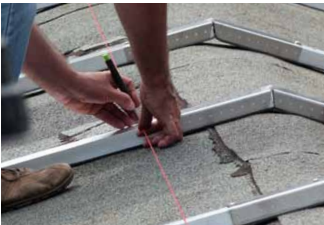
Reihe ilzoclips markieren.
