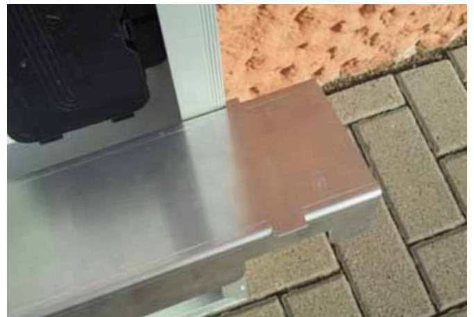
Zur Längeneinstellung schmale Nasen am Modulrahmen andrücken.
