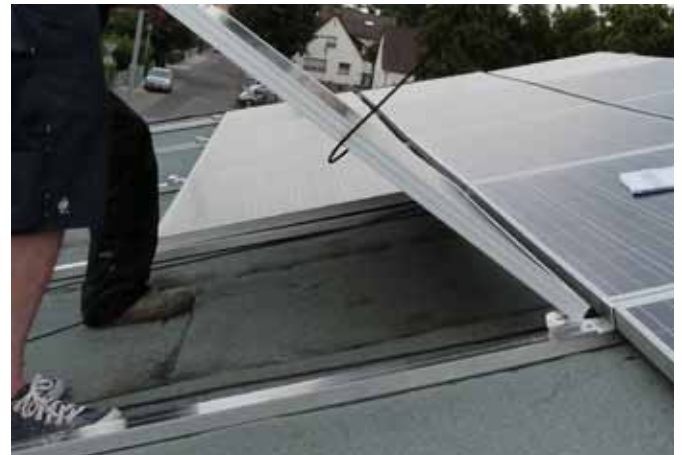
Beim Ablegen, Kabel weiterführen
