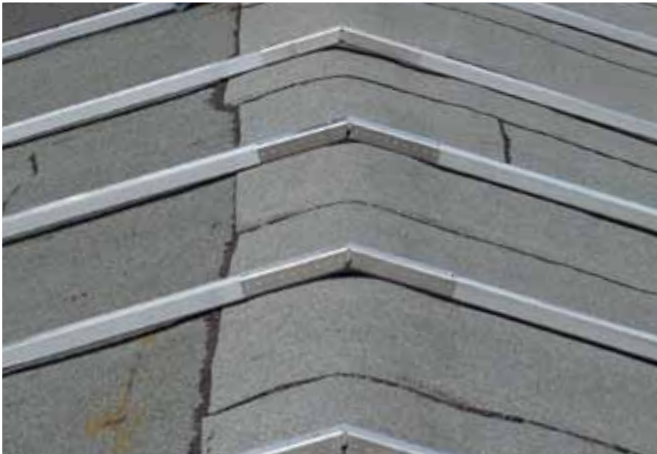
Schienenpaare sauber auflegen.
