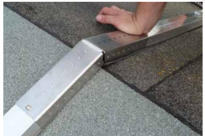
Firstverbinder passend biegen.
