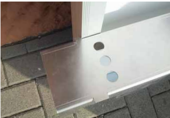
Zur Längeneinstellung schmale Nasen am Modulrahmen andrücken.
