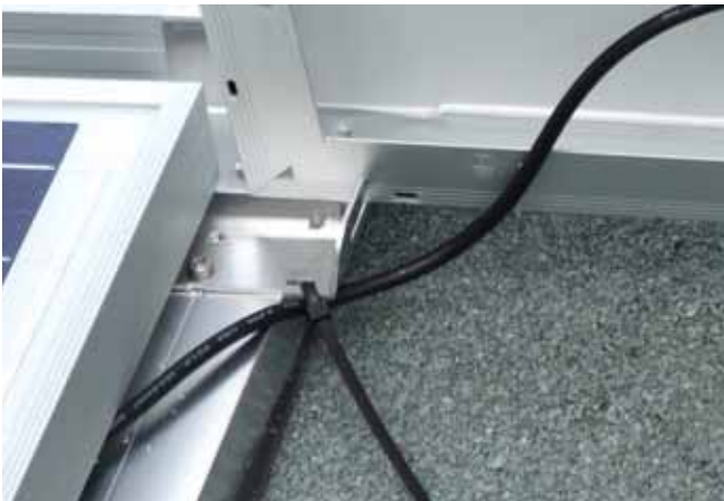
Kabel an Öse im ilzoclip fixieren.
