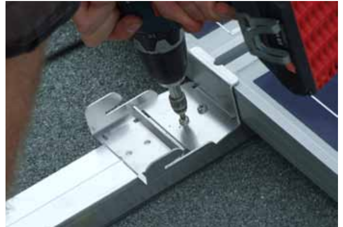
ilzoclip mit Z-Kantung auf die Modulrahmen schieben und verschrauben.
