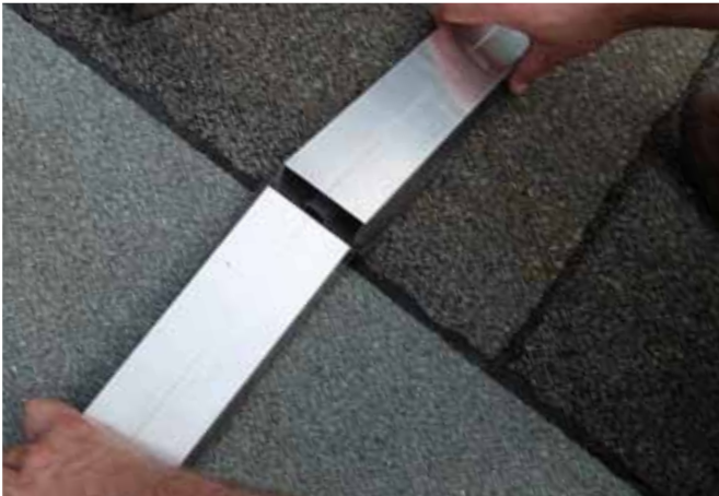
Schienen am First stoßen.
