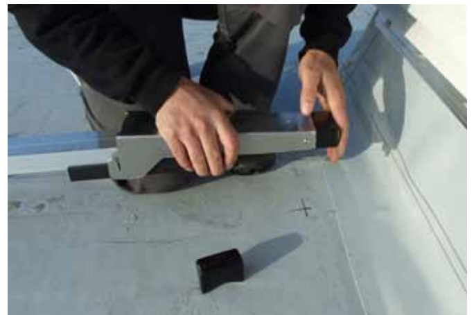
Kappen an Rohrenden anbringen.
