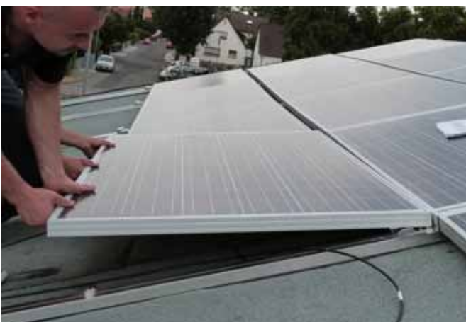
Modul nach oben schieben und
