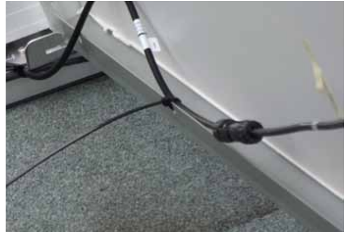
Kabel in Steckernähe fixieren.
